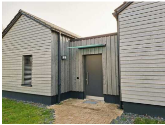
Eingang Haus ULME (EG)
