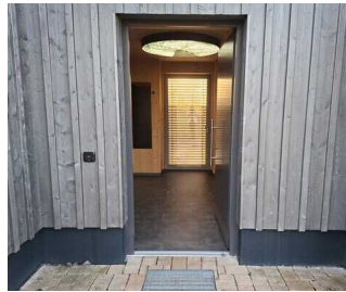
Eingang Haus ULME (EG)
